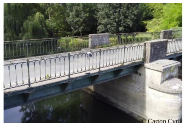
Installation du système MWT sur un pont
