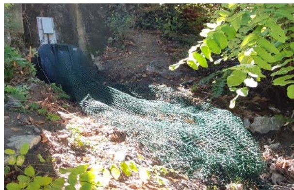
Illustration 24 : Filet sur déversoir d'orage, Hydrosac Maxi® - Berlognière à Grenoble (38), 2019 (Crédit : Hydroconcept)
