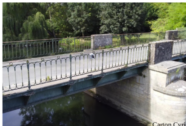
Installation du système MWT sur un pont
