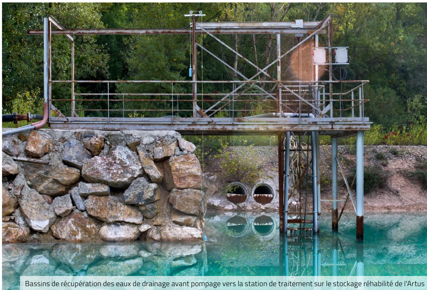
Bassins de récupération des eaux de drainage avant pompage vers la station de traitement sur le stockage réhabilité de l'Artus
